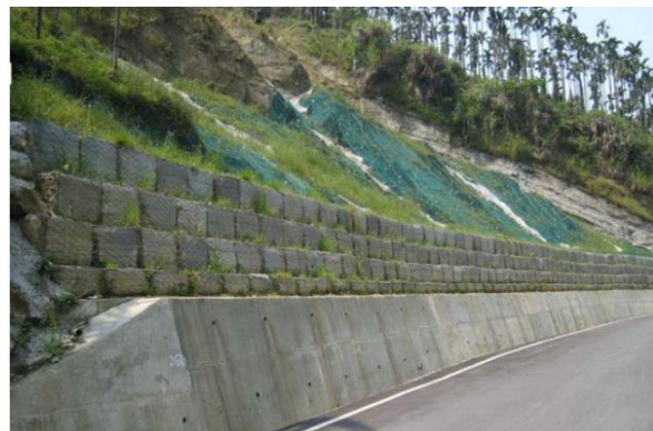
b. Postavljeni gabioni
